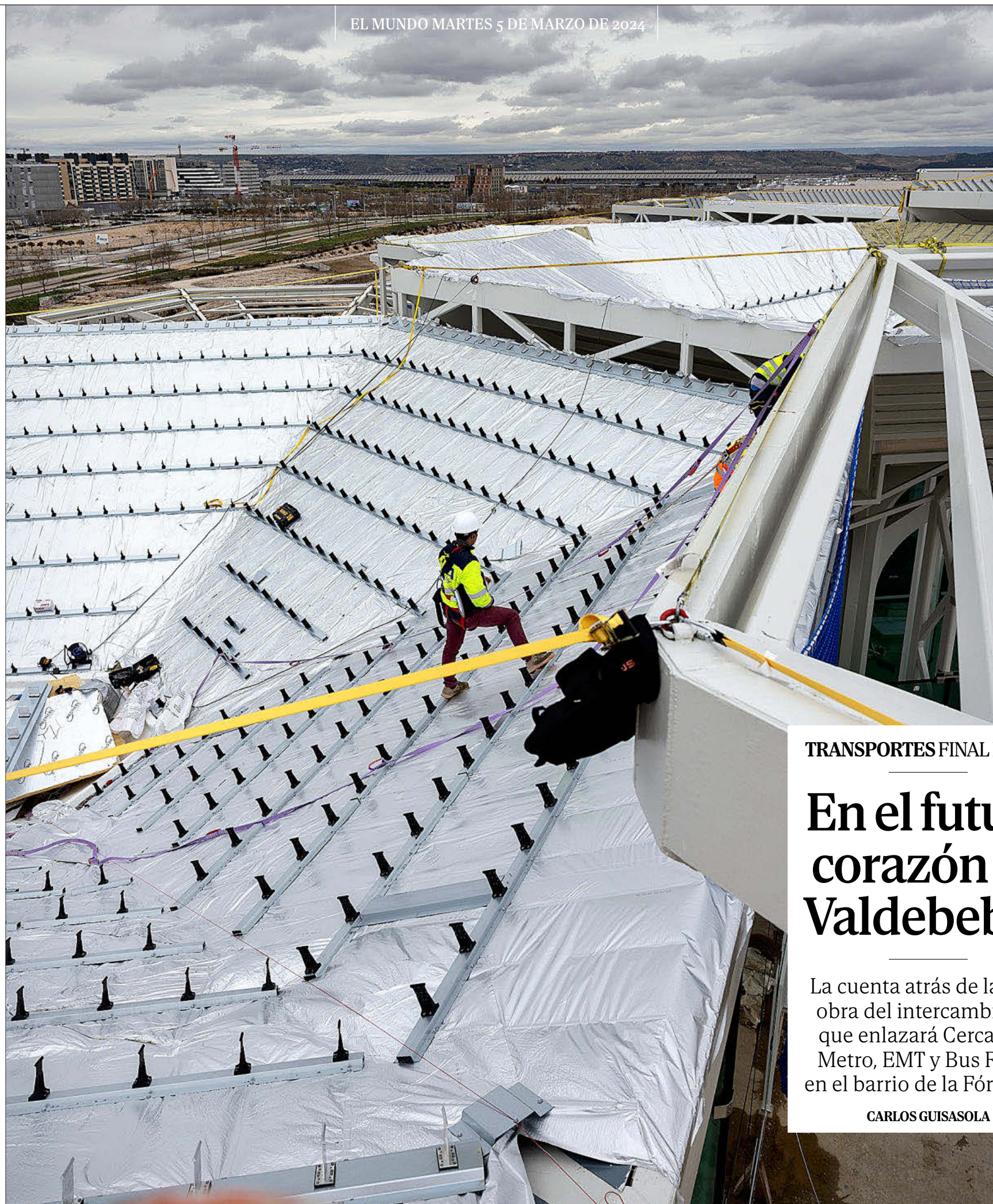
Un operario, ayer, sobre la cubierta del intercambiador de Valdebebas. ALBERTO DI LOLLÍ
