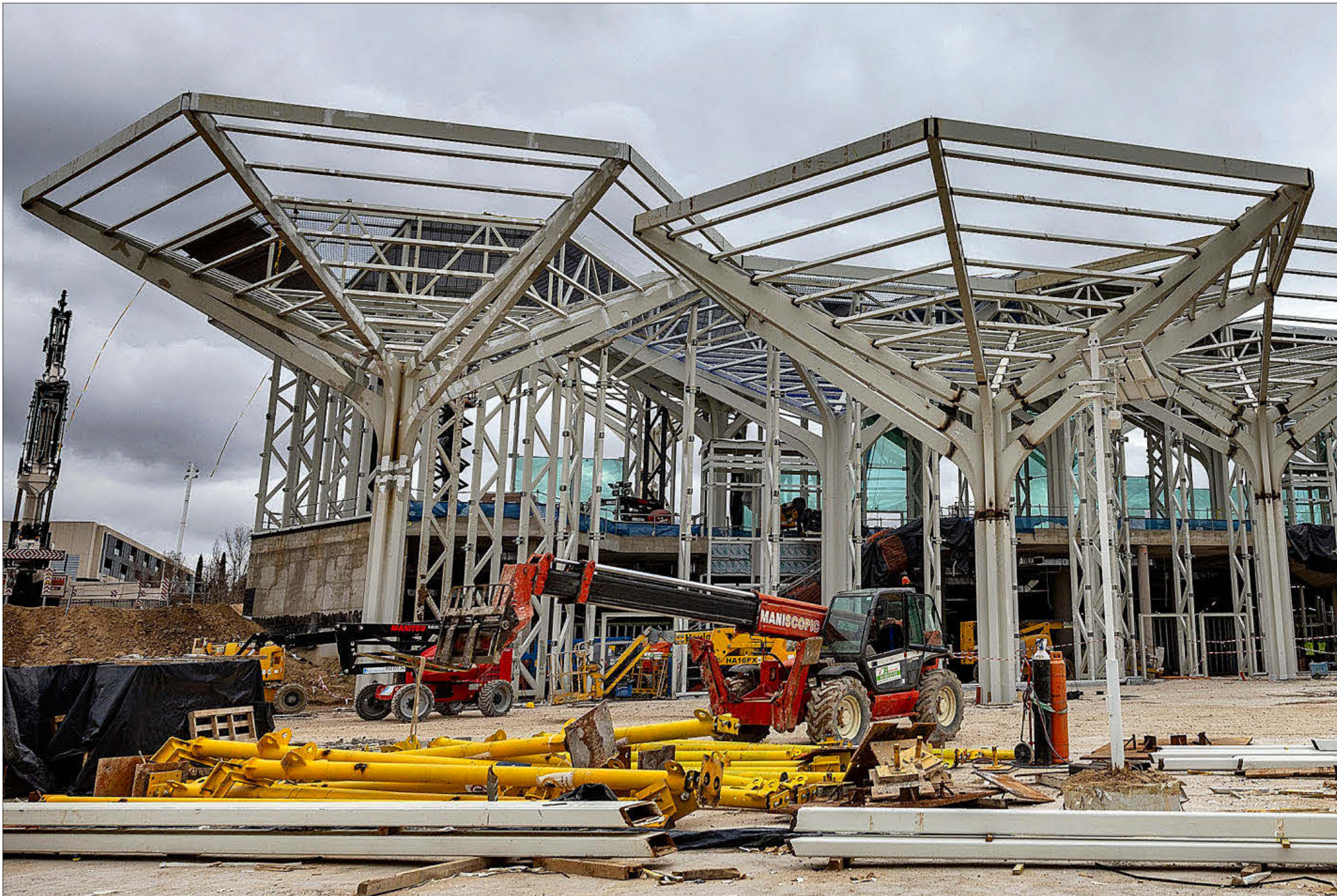
Las obras del futuro intercambiador de Valdebebas, con los 17 'palmeras' de acero que ejercerán de cúpula de la infraestructura. ALBERTO DI LOLLI
